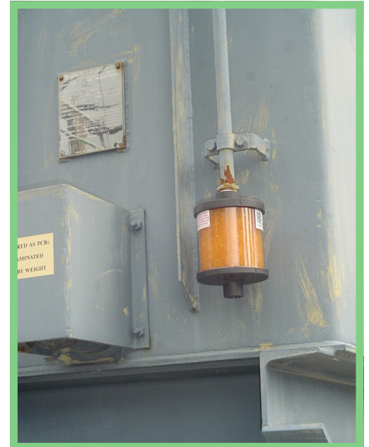
Respiradero para transformador tamaño R
